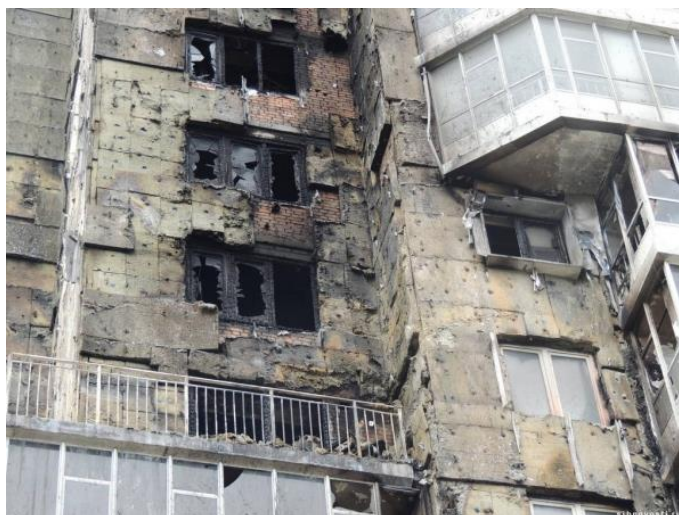
Рис. 1. Пример повреждения строительных конструкций жилого многоквартирного дома, вызванных пожаром
